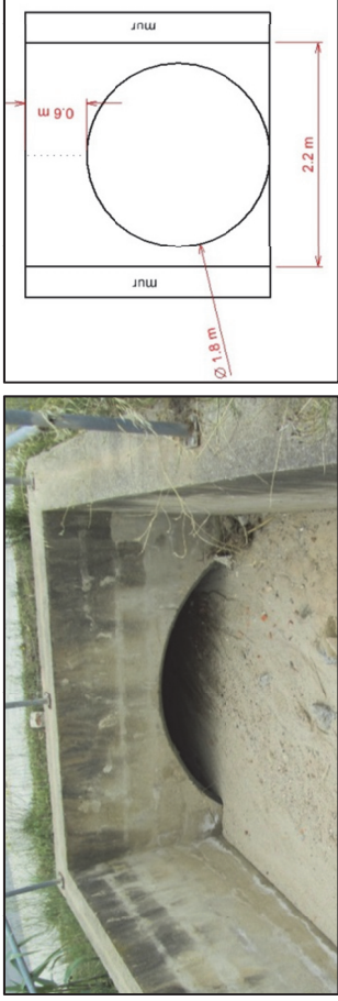
Figura 77. Estructura O02, culvert del carrer Fragata Paulita, sobre el rial de Can Segarres.
