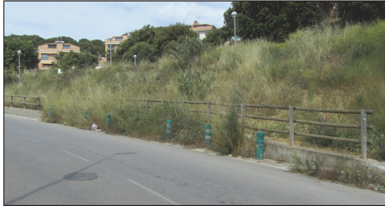
Figura 96. Final de la canalització del rial de Lladoners
