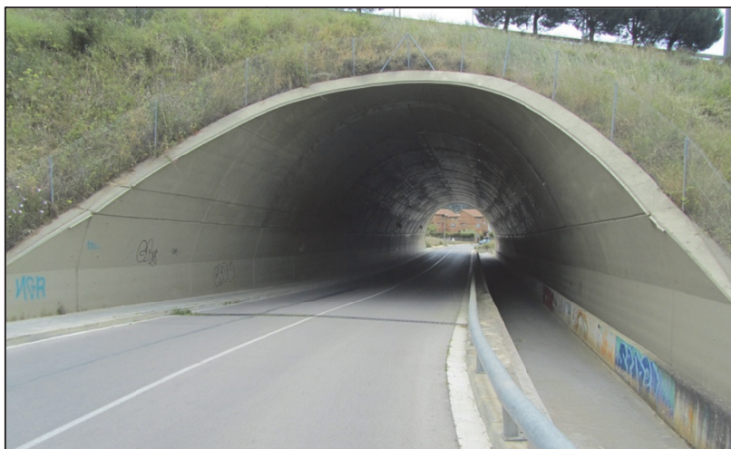
Figura 90. Segon tram canalitzat del rial de Can Figuerola, al seu pas per sota l'autopista C-32.
