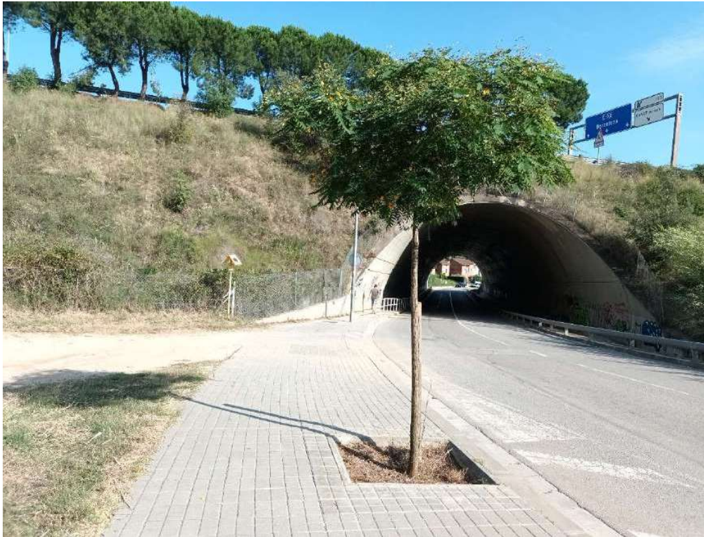
Fotografia actual del túnel que travessa l'autovia C-32 i dona accés des del centre urbà cap al polígon industrial on s'ubica la zona d'equipaments esportius.
