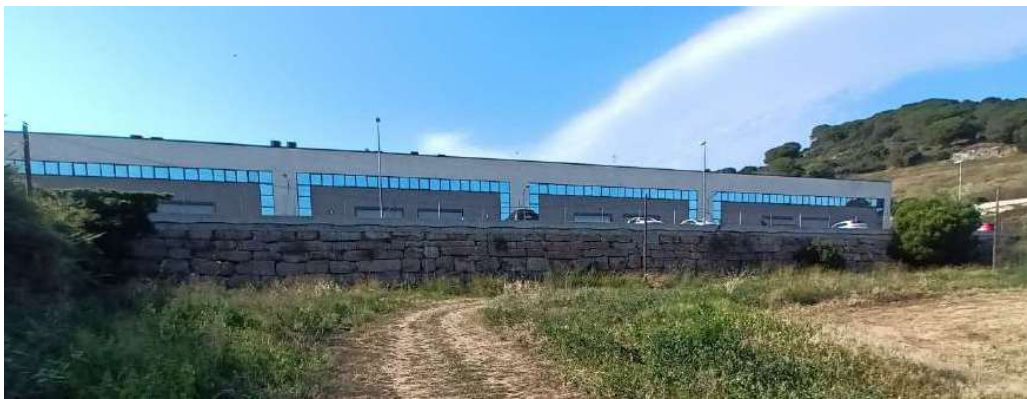
Fotografia actual amb visió sobre la parcel·la veïna on s'hi ubiquen naus industrials sobre un desnivell d'uns 5 m configurat amb un mur de rocalla.
