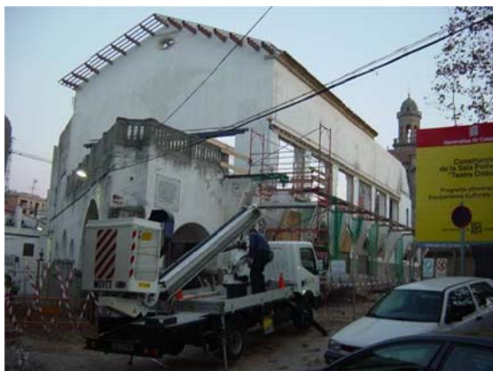
Estat de les obres a novembre de 2007.
