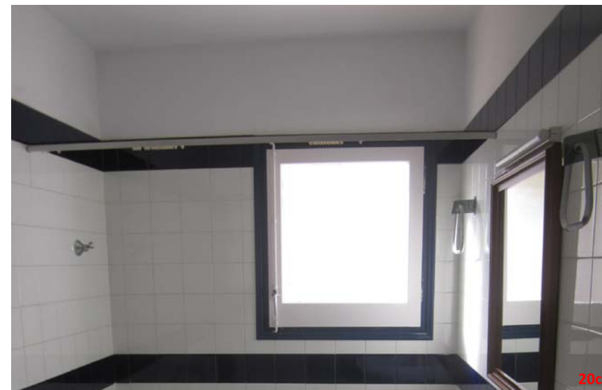
Sanitari antic habitatge Arxiu GAA. Data 22/11/12
