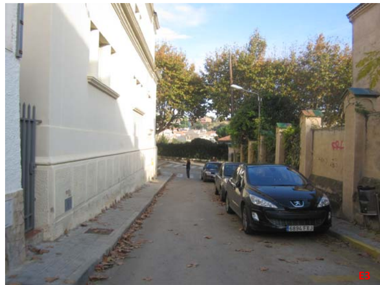
Façana c/Ravalet, sud
