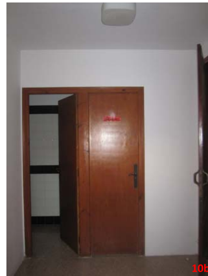
Vestíbul sanitari Arxiu GAA. Data 22/11/12
