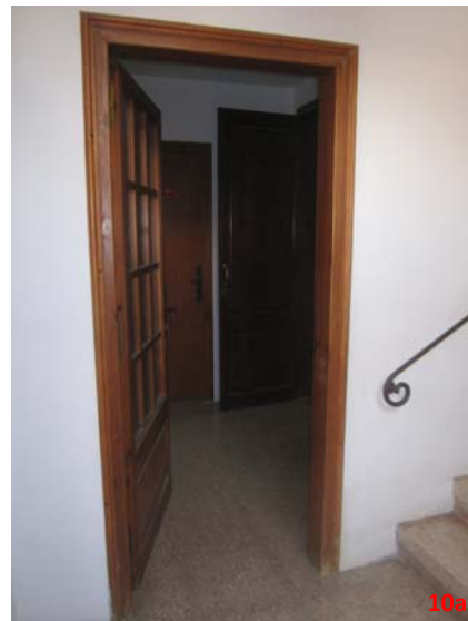
Vestíbul sanitari Arxiu GAA. Data 22/11/12
