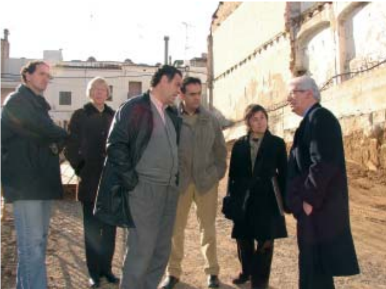
Visita d'obra al futur CAP i aparcament a la riera Gavarra. Desembre 2005
