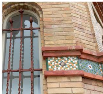
Estació de l'antic tramvia Estación del antiguo tranvía The old tram station Gare de l'ancien tramway Isaac Albèiz, 14
