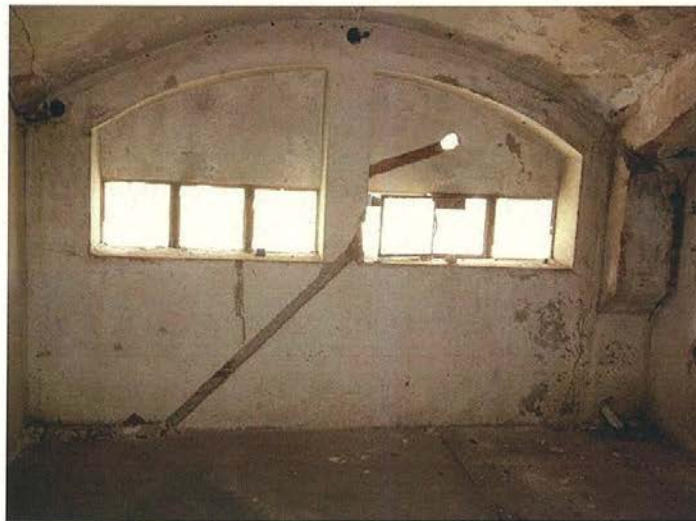
Interior de l'edifici del vapor
