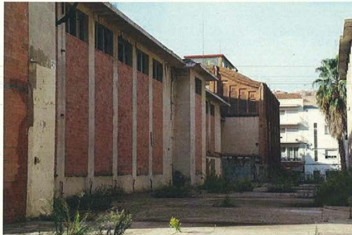
L'edifici d'oficines al fons i la façana lateral de l'edifici dels anys 60
