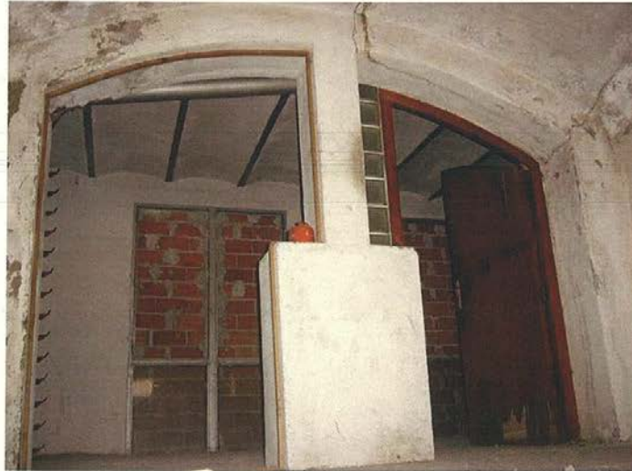
Interior de l'edifici del vapor
