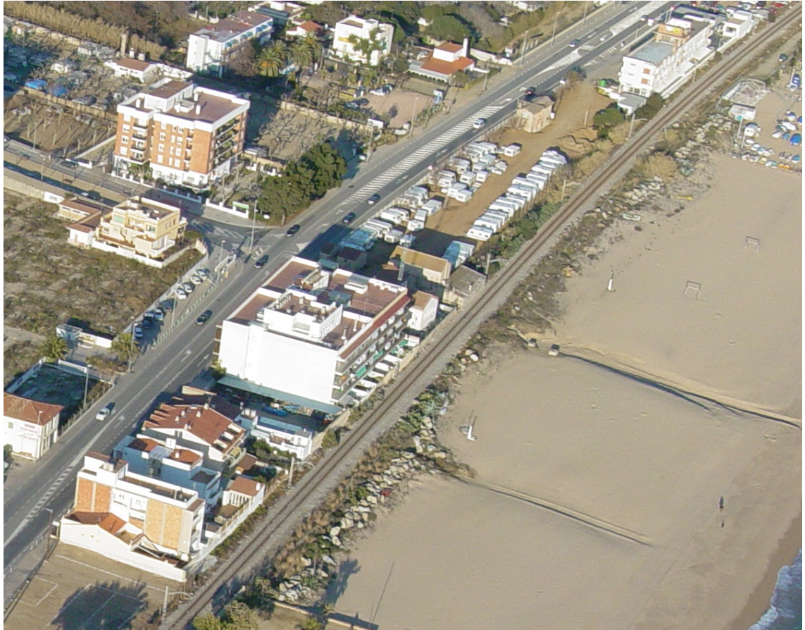
Imatge del tram 4 corresponent als edificis del carrer Drassanes del Pla.
