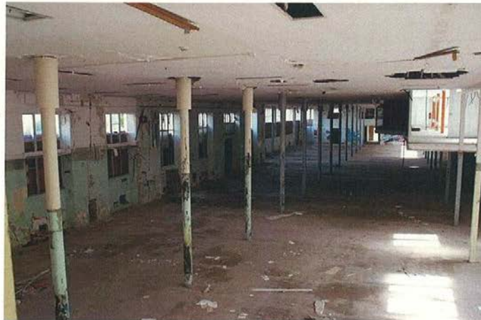
Visió general de l'interior de la nau amb els pilars originals
