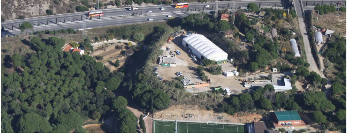
Vista aèria de la deixalleria, situada al límit del sòl no urbanitzable
