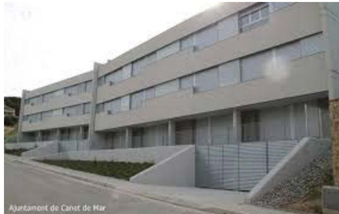
Habitatges dotacionals existents al carrer Rial dels Oms
