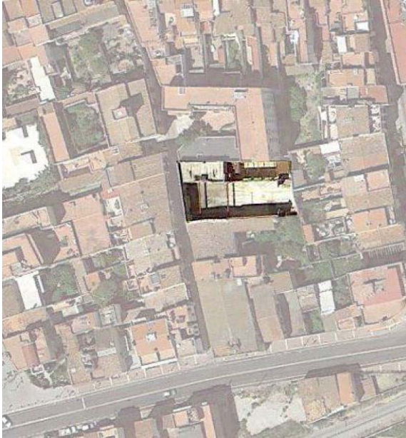
Imatge aèria del solar que correspon a l'antic teatre, que a causa d'un enfonsament accidental va haver de ser enderrocat l'any 2012.
