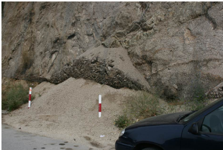
Fotografia 7. Detall de material caigut i atrapat per la malla al la base del tram A2 del talús de la Torre del Moro
