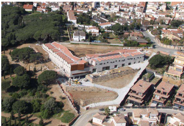
Edifici que acull la fundació privada "Els Garrofers", situat al sector del Grau.
