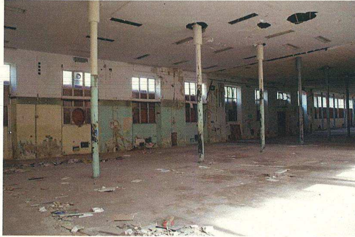
Interior de la nau amb els pilars originals de 1900
