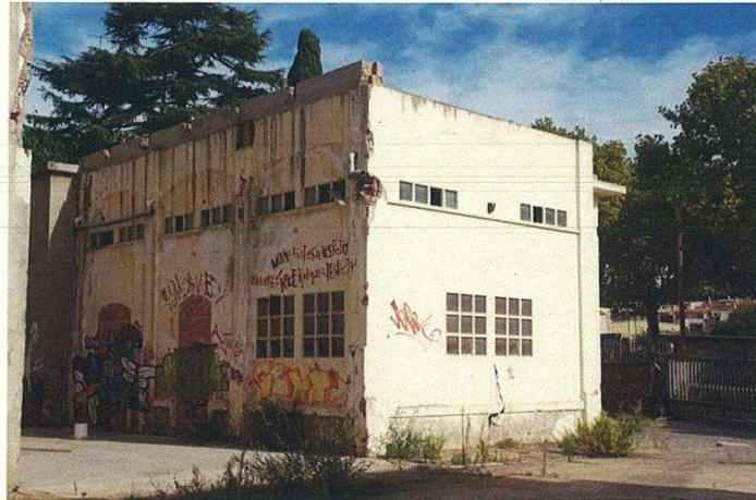
Edifici del vapor
