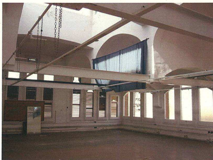
Interior de l'edifici a la última planta amb el lucernari
