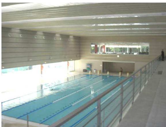
Piscina coberta municipal.
